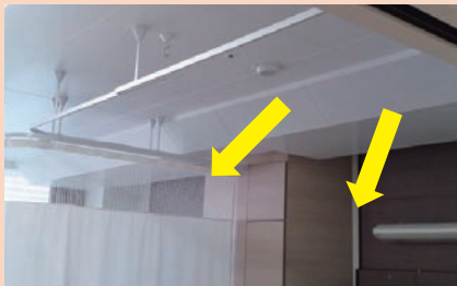
病室の空調 矢印の方向に、きれいな空気が出ています。無音で、風も感じません。
